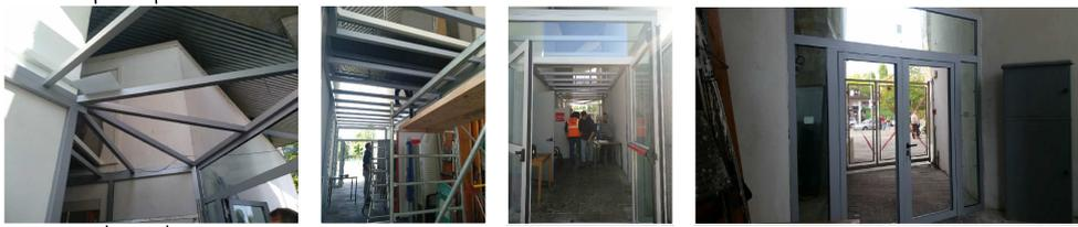
Foto lavori in corso di esecuzione del tamponamento vetrato
